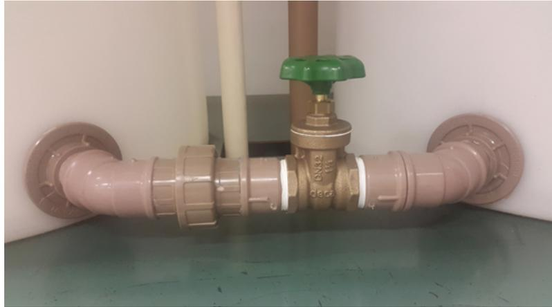
Figura 3.5: Acoplamento entre os tanques T1 e T2 e entre os tanques T3 e T4.
