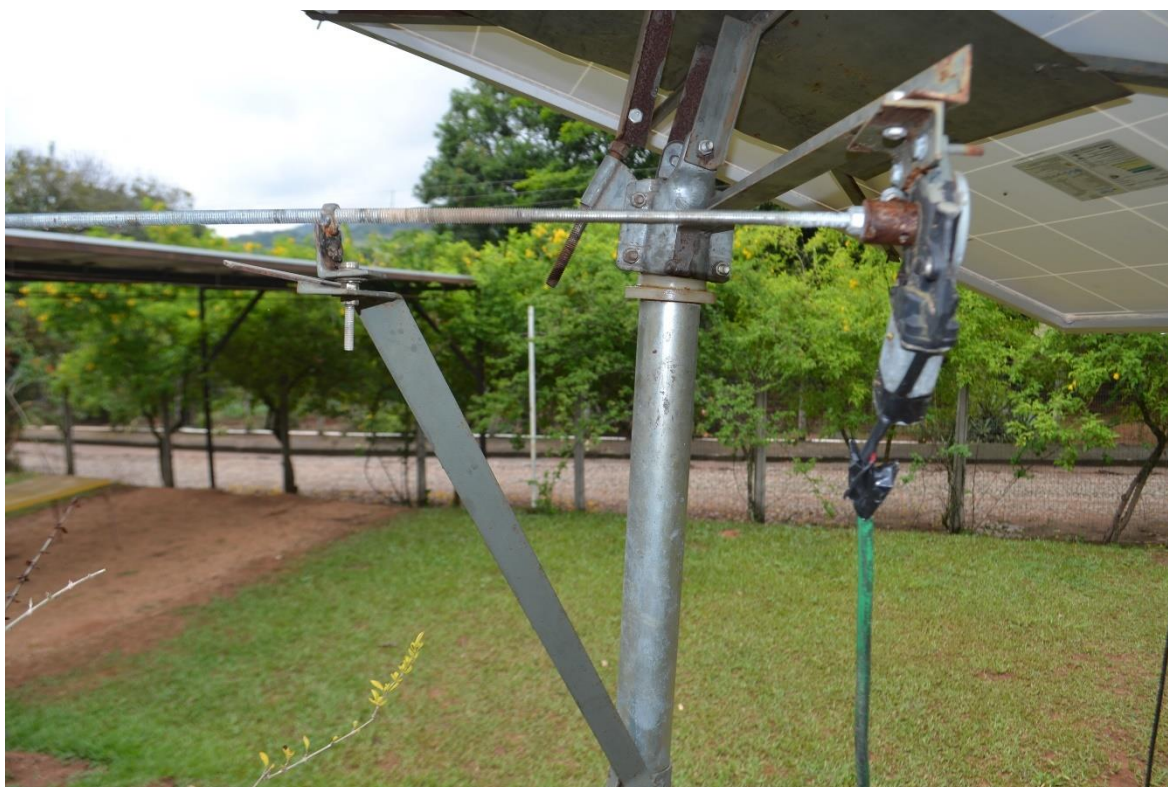
Figura 3.11: Acoplamento da barra roscada ao motor
