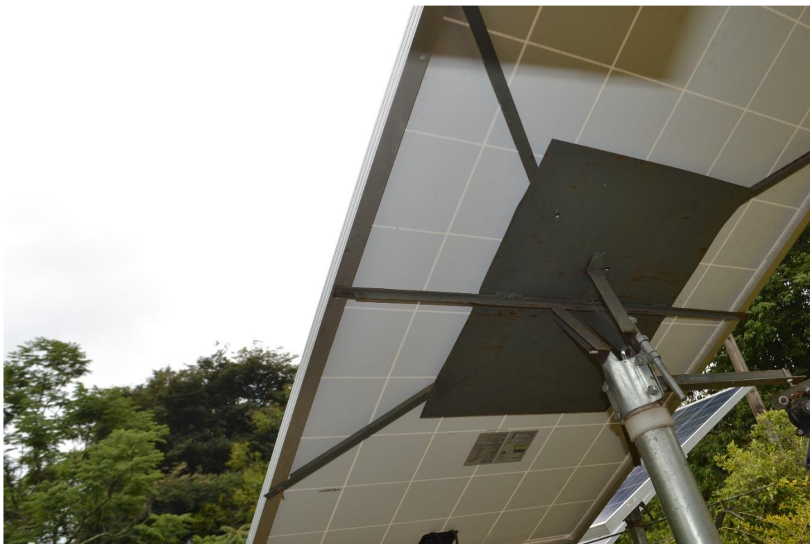
Figura 3.3: Armação para fixação dos módulos.
