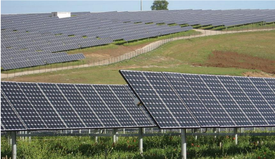
Figura 2.7: Sistema de rastreamento solar com um eixo móvel.[13]
