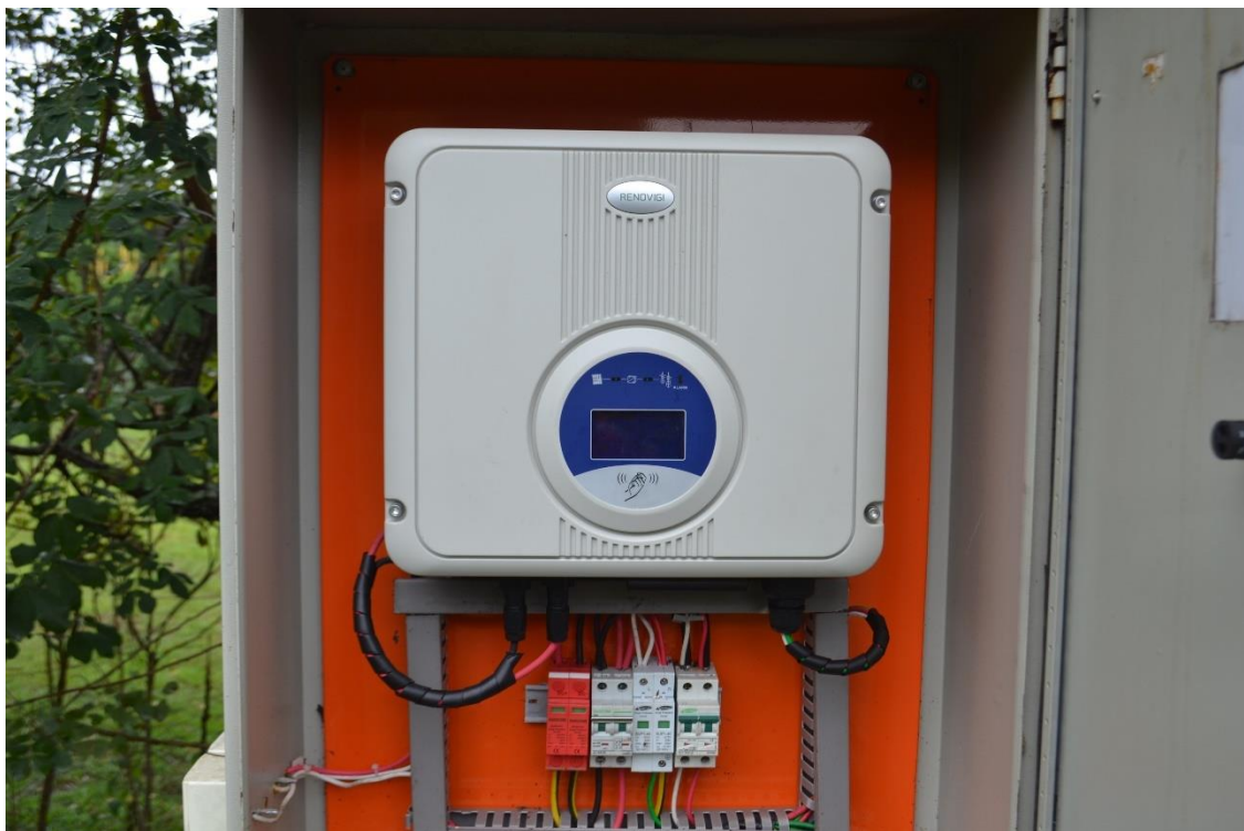
Figura 3.9: Inversor Renovigi 1.6k Plus.
