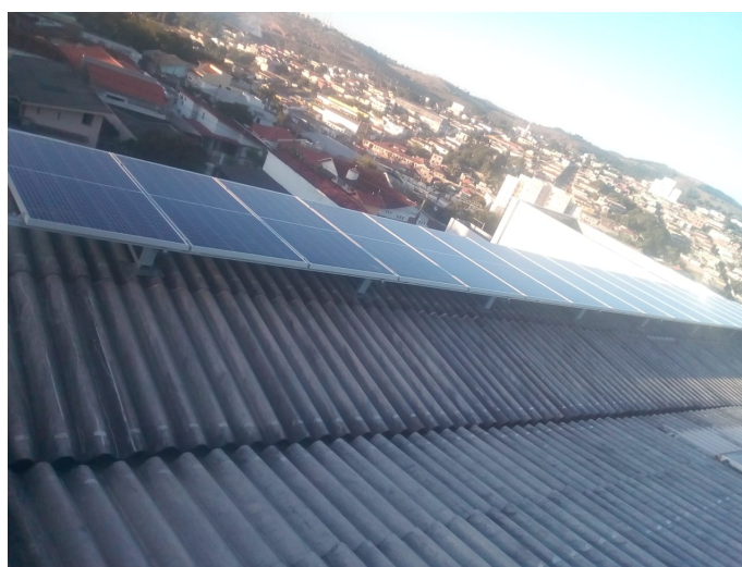
Figura 3.4: Sistema Instalado com estruturas espaçadas do telhado - Planta B
