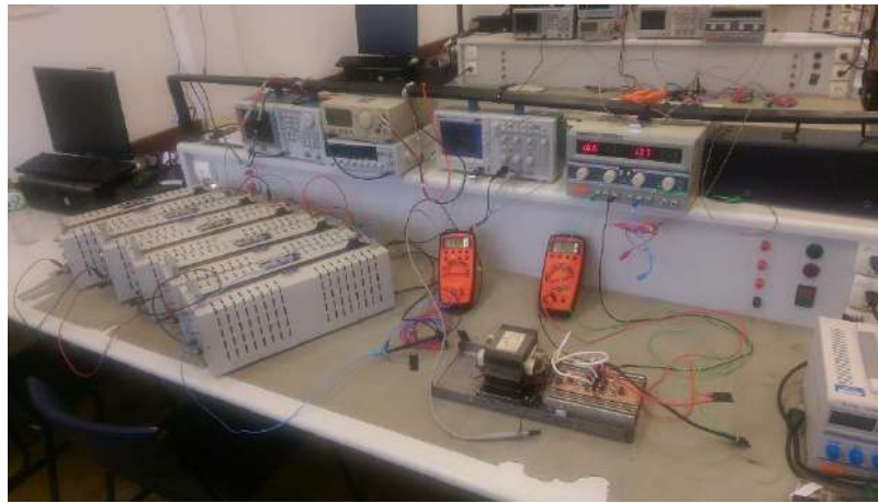
Figura 4.3: Testes no transformador.
