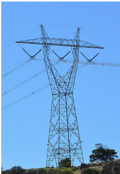
(a) Estrutura de disposição horizontal autoportante. Fonte: < https://pixabay.com/photos/pylon-electricity-power-lines-83790/ >. Acesso em: 22/3/2020.
