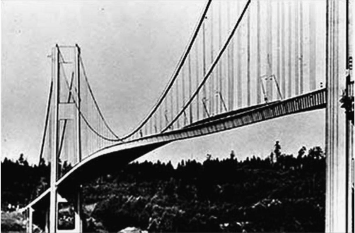
Figura 2.9: Ponte de *Tacoma Narrows* apresentando torção devido a excitação das correntes de vento. Fonte: PLAUT (2008).
