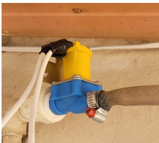
Figura 5.11 – Conexões finais da válvula - Fonte: Autor
