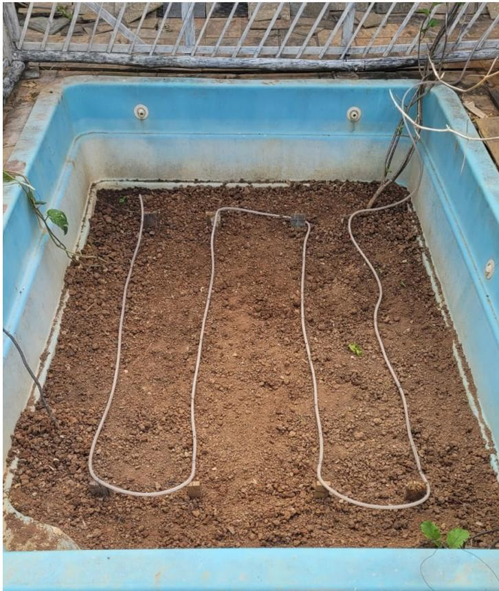
Figura 4.12 – Montagem da mangueira de gotejamento no local- Fonte: Autor
